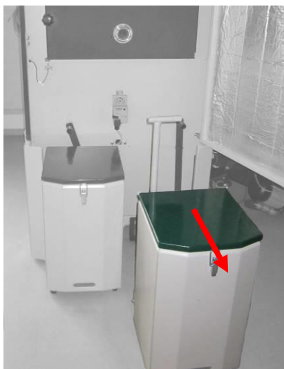
Aschebehälter entkoppeln und vorziehen
