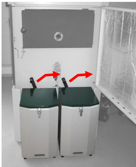
Aschebehälter mit Hebel entriegeln
