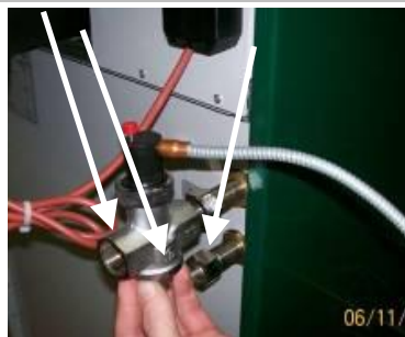
Syphonanschluss Ventil thermische Ablaufsicherung (Zubehör Hersteller)
