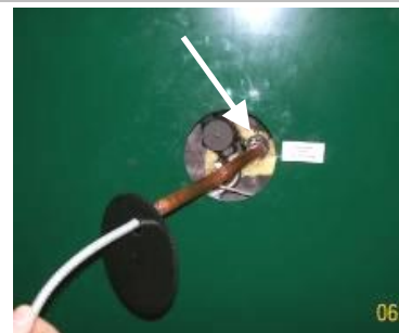
Kapillarrohr in Tauchhülle stecken
