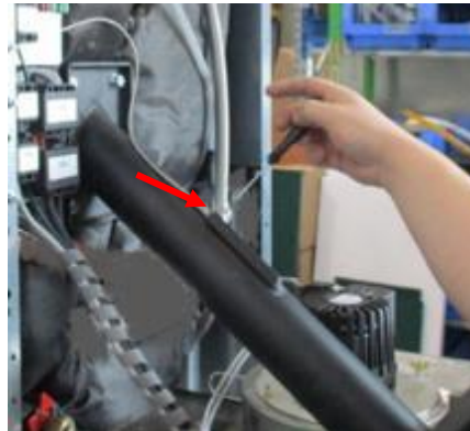
Den Rauchgastemperaturfühler in die Hülse am Kondensatsammelbehälter bis zum Markierungsring schieben und mit der Schraube fixieren. Den Temperaturfühler Einschubkanal in die vorgeschaltete Öffnung am Einschub schieben und mit der Schraube fixieren.
