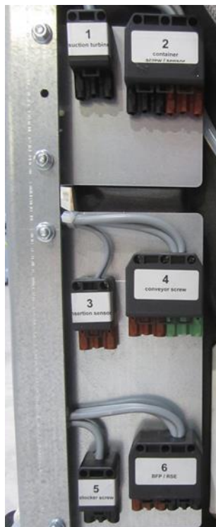
Alle Stecker sind mit Nummern (1, 2, 3...) und entsprechend gekennzeichneten Buchsen (1, 2.1, 2.2, 3...) am Kessel zu verbinden.
