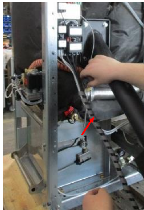
Mit dem Spiralschlauch die Kabel fixieren.
