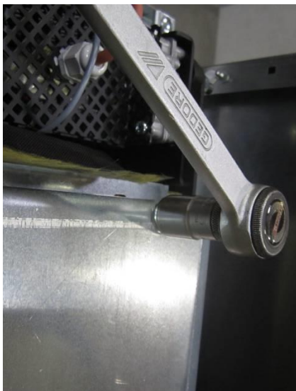
Entfernen des Flugaschendeckels mittels entsprechendem Werkzeug (z.B. Gabelschlüssel oder Ratsche → Größe 17)
