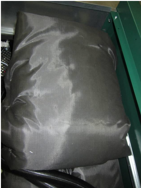
Entfernen der Wärmedämmung
