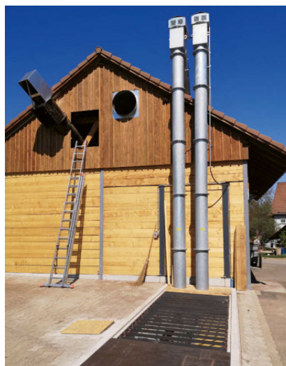
Die Hackschnitzel gelangen vom unterirdischen Fülltrog unter das Dach, wo der Dreck ausgesiebt wird. Ein spezielles Sieb trennt im Nebenraum das Ausgangsmaterial vom Dreck, der direkt abgefahren werden kann.
